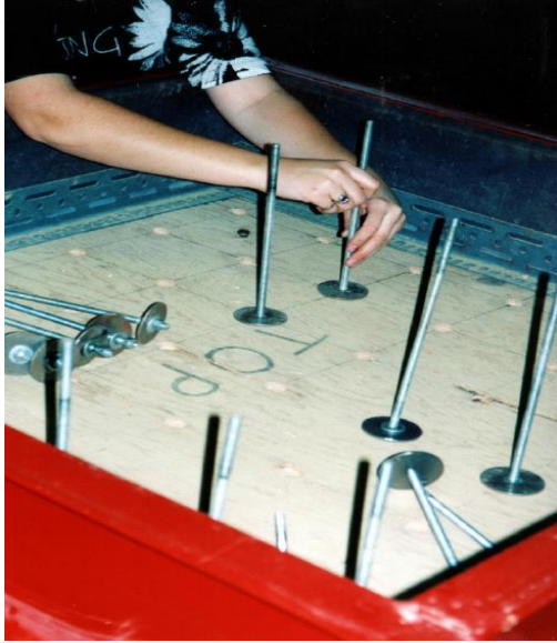
⑤定位安装锚杆
