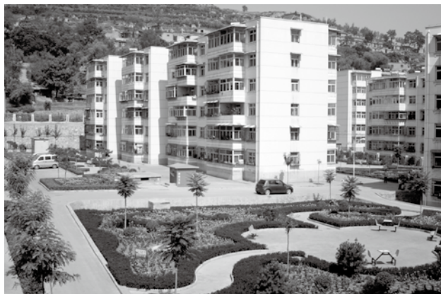
改造后的棚户区新貌
